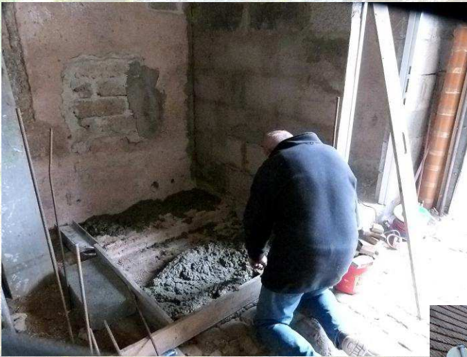
Volker Kubon beim Betonieren der Standfläche für den Wassertank.
