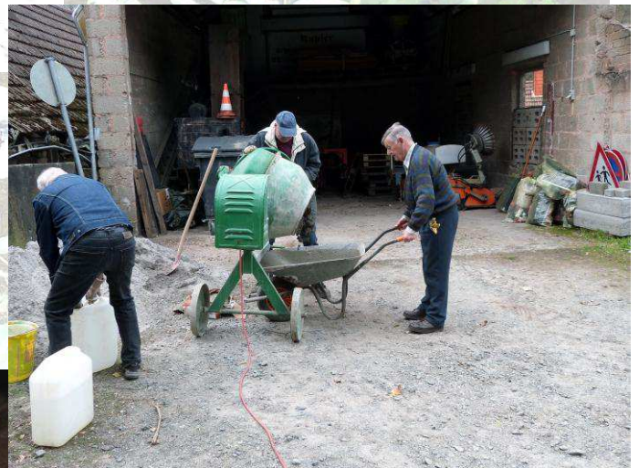
Volker Kubon beim Betonieren der Standfläche für den Wassertank.
